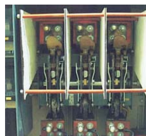
Eine überhitzte Verbindung
