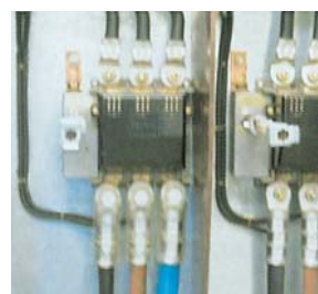
Ein lockeres überhitztes Kabel
