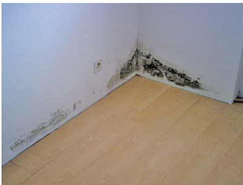
Schimmelbefall und verminderte Dämmeigenschaften durch aufsteigende Feuchte und Kondensatbildung
