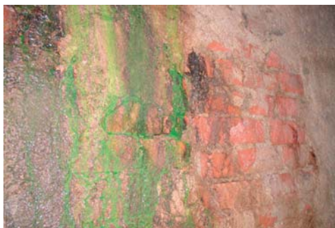
Erfolgreiche Überprüfung mit Färbemittel
