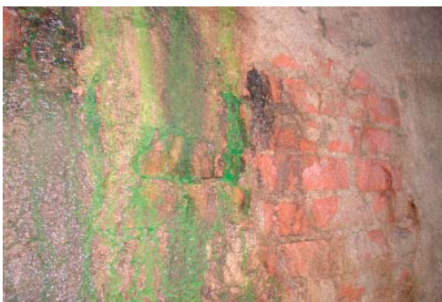
Erfolgreiche Überprüfung mit Färbemittel
