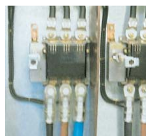
Ein lockeres überhitztes Kabel
